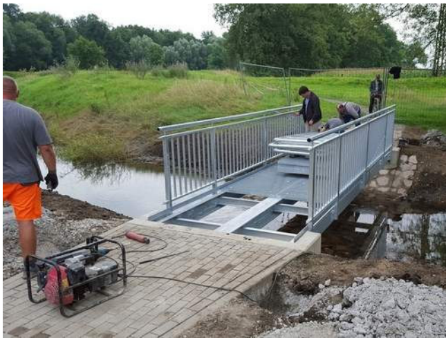
Die neue Ehlebrücke wurde dieser Tage aufgebaut. Foto: Peter Fries
