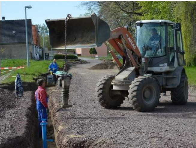
Arbeiten im ersten Bauabschnitt laufen seit Ende März. Foto: Nora Stuhr
